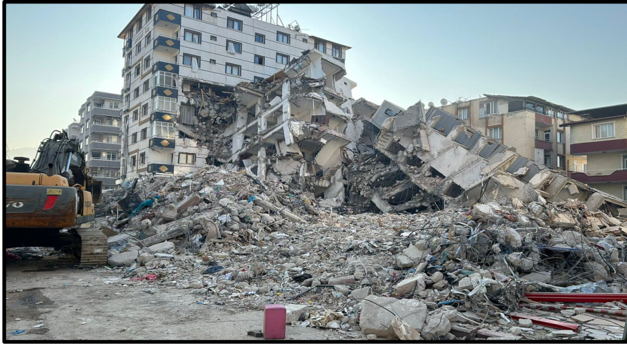
Şekil 4: Burulma davranışı göstererek yıkılmış bir bina, Hatay (TMMOB MO ve İMO İzmir Şb. 2023)
