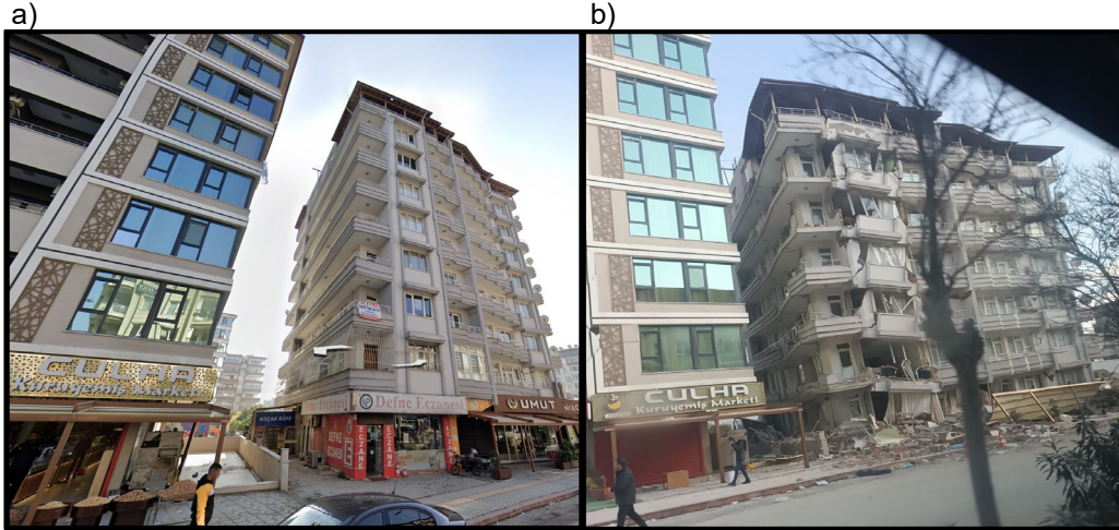
Şekil 9: Yumuşak katlı başka bir bina; a) deprem öncesi, b) deprem sonrası, Hatay (TMMOB MO ve İMO İzmir Şb. 2023)
