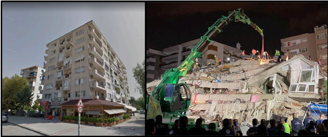
Şekil 25: Doğanlar Apartmanı deprem öncesi ve sonrası (Toptaş 2020) Figure 25: Doğanlar Apartments before and after the earthquake (Toptaş 2020)
