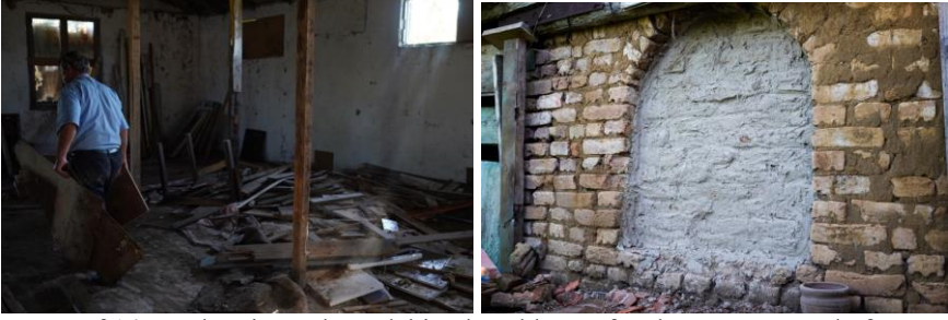
Fotoğraf 14: Atölyenin üst katındaki yakacaklar ve fırınlama aşamasında fırının doldurma kısmının kapatılmış görüntüsü
