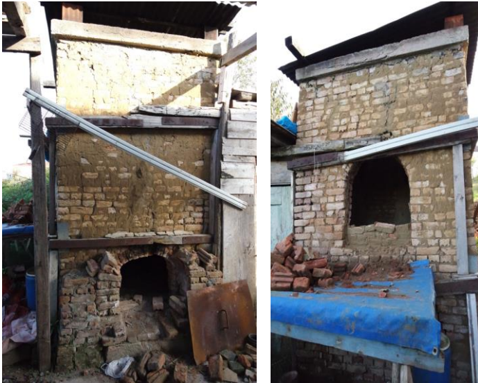
Fotoğraf 12: Salih Usta'nın fırınının önden görüntüsü, altta ateş yakma bölümü ve yüklenme bölümü.
