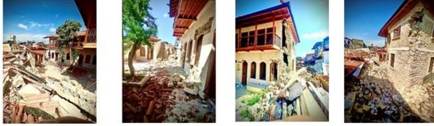
283 numaralı parsel yapısı
