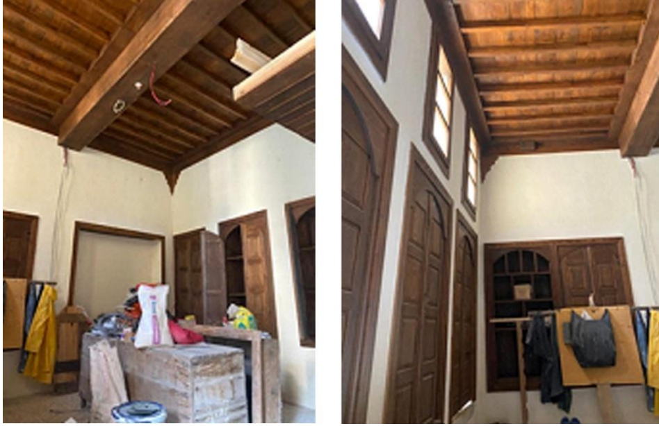
Şekil 10. 283 parsel yapısına ait iç mekan görselleri
