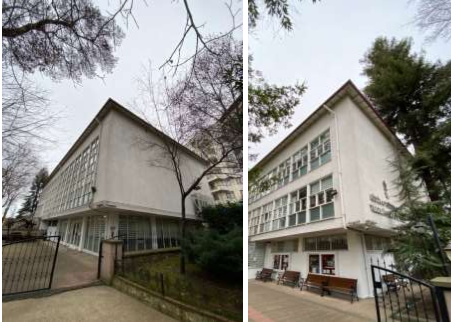
Şekil 18. Trabzon İl Halk Kütüphanesi Doğu ve Batı Cephesi (Yazar arşivi, 2023)
