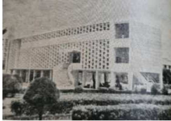
Şekil 8. Sıcak iklimli bölgelerde güneş kırıcı etki sağlamak amacıyla yapılmış cephe sistemi – Akra Merkez Kütüphanesi – Gana (Galvin ve Buren, 1963)
