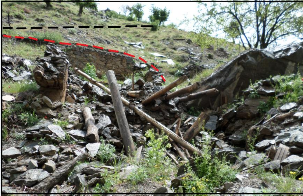
Şekil 3.8. Kaya düşmesi ve kayma olayının geliştiği yamacın sonraki hali
