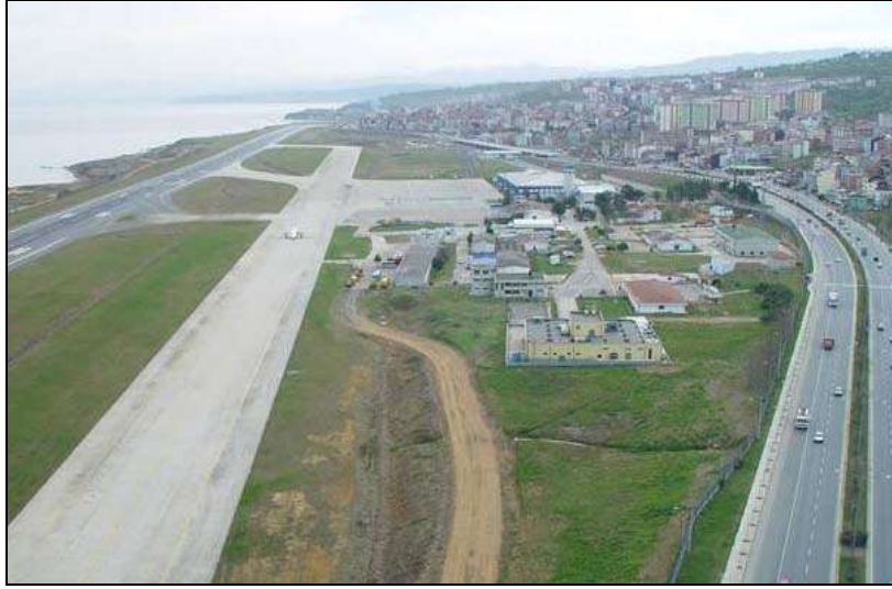
Foto 3. Trabzon Havalimanı, Samsun-Sarp Karayolu ve Pelitli Mahallesi ( www.DHMI.gov )
