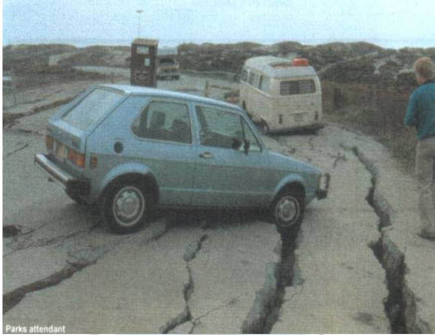
Şekil 4.7.1989 Loma Prietadepreminde devlet parkı yakınında oluşan yanıl yayılma [15].
