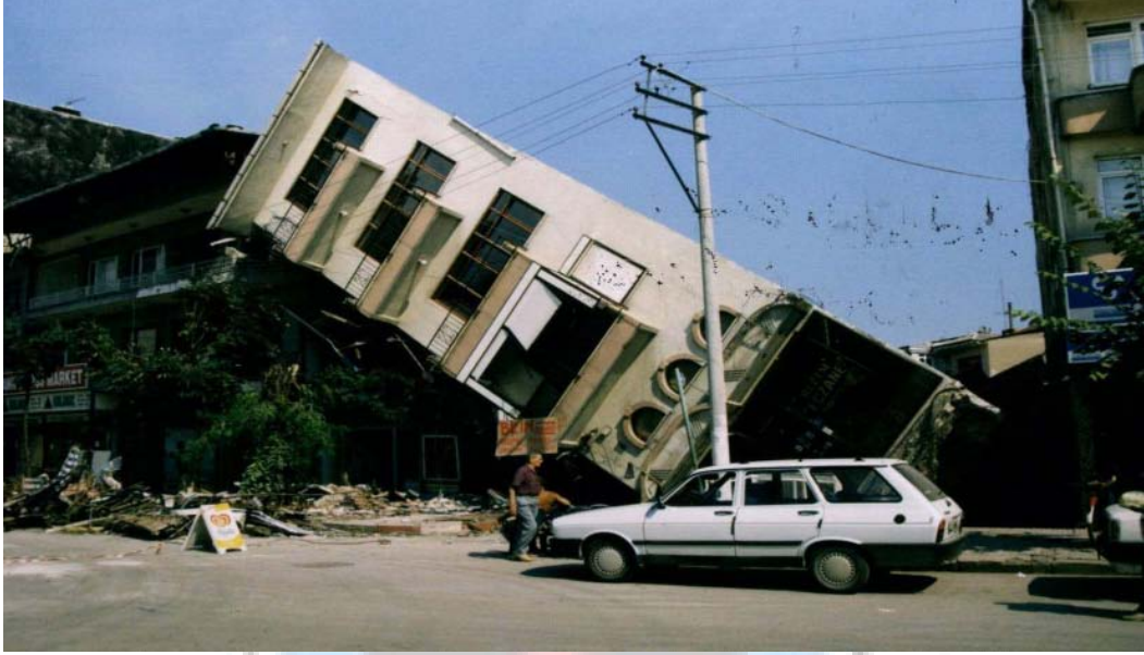
Şekil 4.11. 1999 Türkiye depreminde Adapazarı ilinde sınılaşma sonucu devrilen binalar [16].
