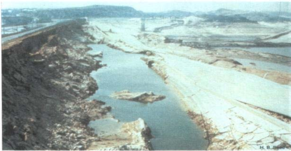
Şekil 4.5. 1971 depreminde The Lower San Fernando Barajında oluşan akma [15].
