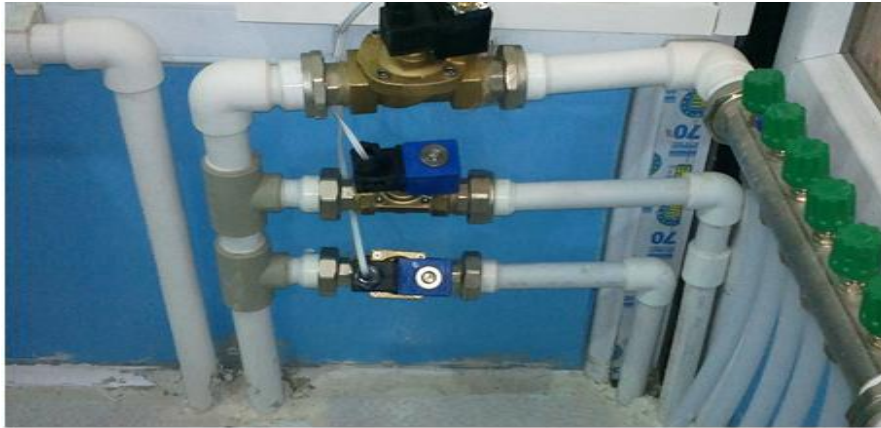
Şekil 1. Sera içi ısıtma ve sulama dağıtım kollektöründeki selenoid vanalar.
