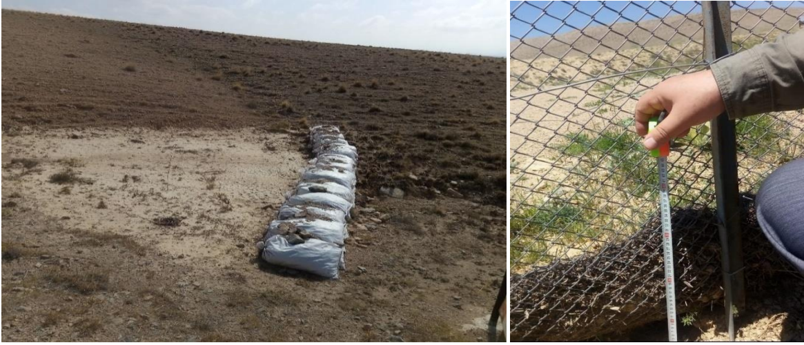
Şekil 10. Merada uygulanan settelerde tutulan erozyon ile taşınan toprak(çuval ve tel sette)
