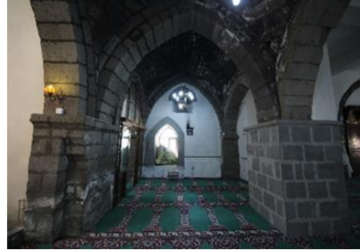
Şekil 17. Orijinal destek ve örtü sistemi
