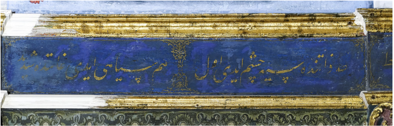
6 Kuşak yazısının restorasyon öncesi görünümü
