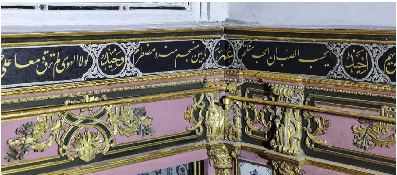
14 Yazı kuşağının restorasyon sonrası görünümü
