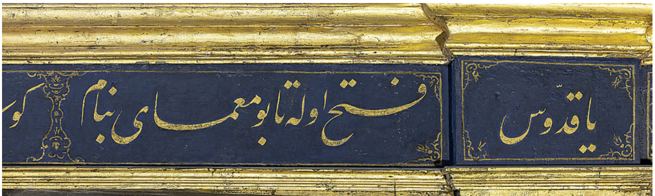
10 Kuşak yazısının restorasyon sonrası görünümü
