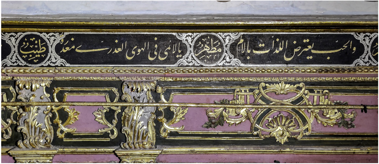
13 Yazı kuşağının restorasyon sonrası görünümü
