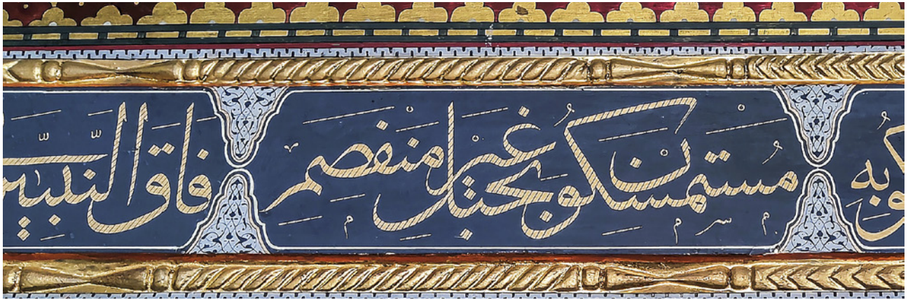
21 Yazı kuşağının restorasyon sonrası görünümü
