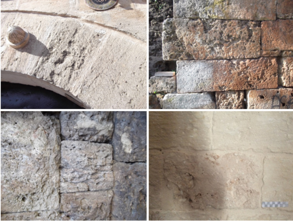
Şekil 4. Mardin'deki tarihi yapılarında gözlenen değişik form ve boyuttaki alveolar ayrışma örnekleri ile taşın içerdiği minerallerinin ayrışması yoluyla veya dış biyolojik etmenlerden dolayı, taşın orijinal renginin değişime uğraması sonucunda oluşan renk değişimi şeklinde bozunma (üst-sağ).
