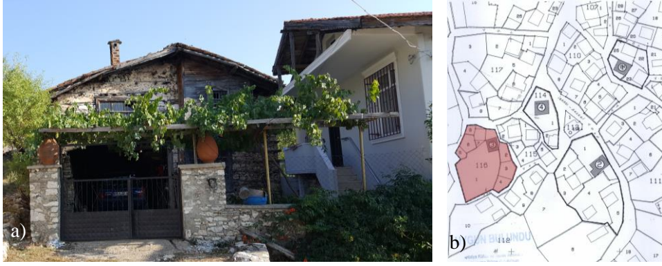
Şekil 18. 116 Ada 1 parselde bulunan tescilli yapının kuzey cephesi (a) ve parsel yerleşim krokisi (b).
