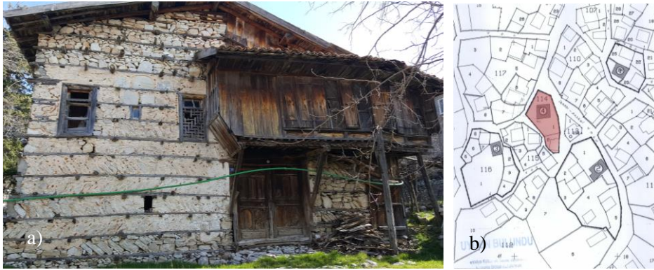
Şekil 22. 114 ada 1 parselde bulunan tescilli yapının batı cephesi (a) ve parsel yerleşim krokisi (b).
