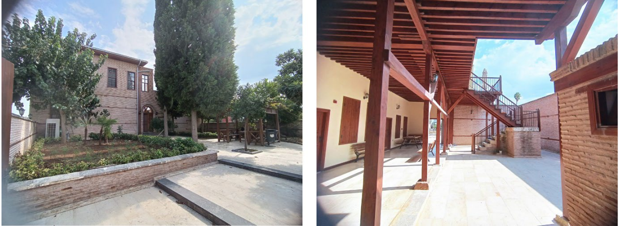
Şekil 2. Yapının Batı (Giriş) Cephesinden ve İç Avludan Görünüşü
