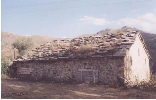
Resim 11: Güzeloluk Köyü Kilisesi Kuzey Cephe
