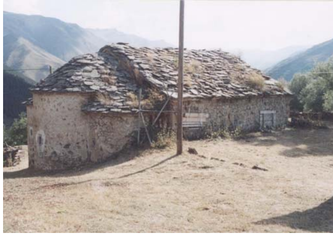
Resim 19: Güzeloluk Köyü Kilisesi Kuzeydoğu Cephesi
