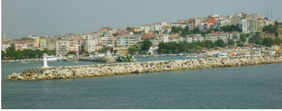
Foto 2. Silivri dalgakıran ve sahil kesiminden bir görünüm.
