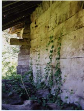
Resim:7 Batı cephesi ve revak kısmı.
