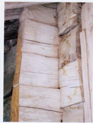
Resim:4 Karaboğaz yöntemi ile kalasların birleştirilmesinden görünüm. Kuzeydoğu köşesi.
