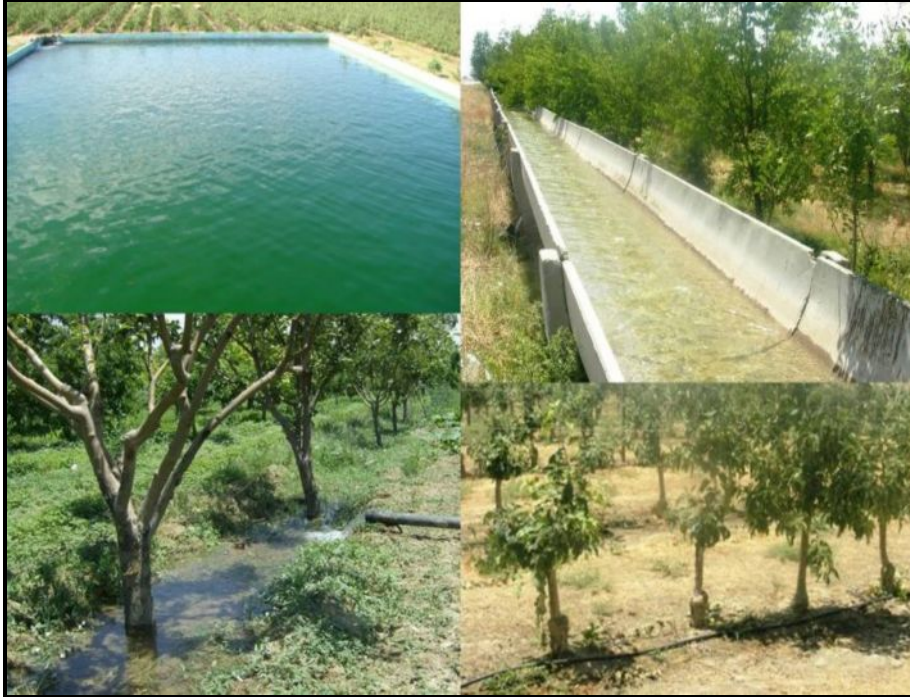
Foto: 1- Ereğli'de Meyve Bahçelerindeki Su Sistemleri
