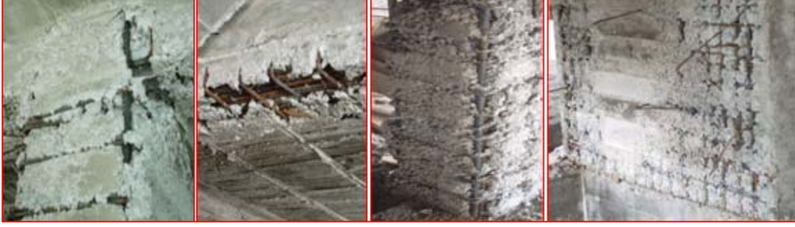
Şekil 11. Pas payı uygulama hataları.
