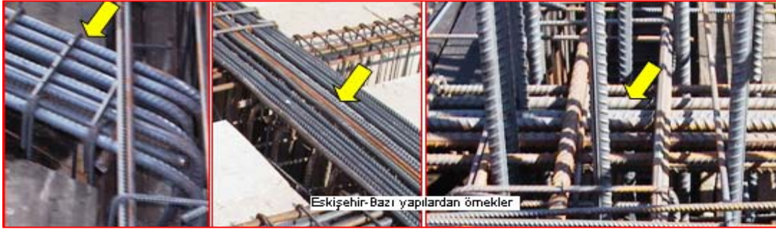
Şekil 13. Donatılar arası aralık kriterlerinin uygulanmadığı uygulamalar [20]
