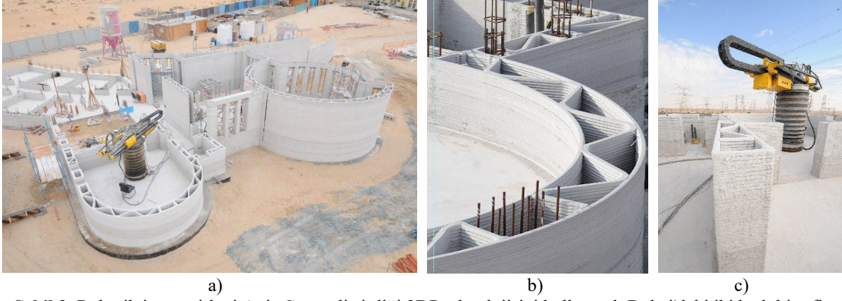
Şekil 2. Robotik inşaat şirketi Apis Cor, geliştirdiği 3DP teknolojisini kullanarak Dubai'deki iki katlı bir ofis yapısı olan dünyanın en büyük 3D baskılı binasını inşa etti [19].
