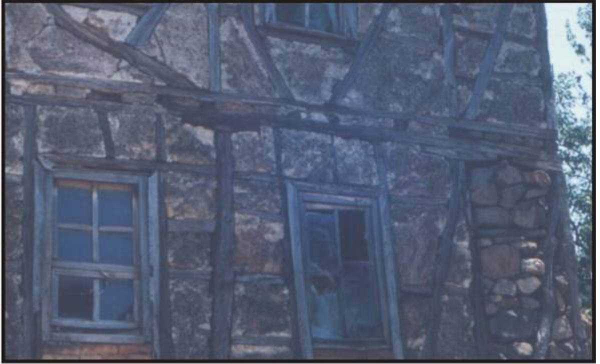
Foto 3: Ahşap iskeletin, kolay işlenen bir malzeme olan travertenle doldurulması sonucunda inşa edilmiş bir mesken duvarının yakından görünümü (Akharım köyü).
