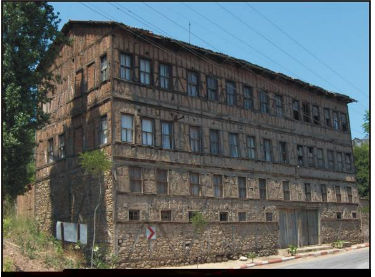
Foto 4 A: Ahşap ve kerpiçten faydalanılarak inşa edilmiş olan bir meskenin genel görünümü (Dereköy) B: Aynı meskenin yakın plan görüntüsünden de anlaşılacağı üzere, ahşap iskelet oluşturulduktan sonra arada kalan boşluklar kerpiçlerle doldurularak mesken tamamlanmıştır.
