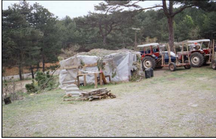
Foto 1. Barakalar ahşaptan olup, düzensiz bir şekilde tahtaların çakılması ile inşa edilmekte, daha sonra üzeri naylon örtü ile kaplanmaktadır.
