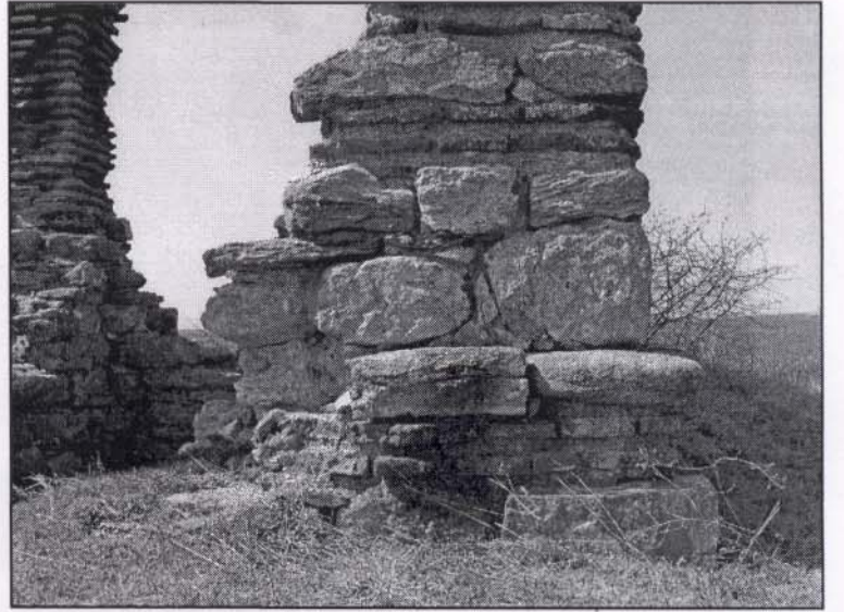
7. Edirne- Süloğlu- Tatarlar Köyü Türbesi'nin oturtmalığının dıştan detayı
