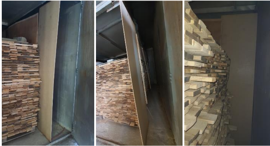
Şekil 11. Dikey boşluk kapatma levhasının fırın içerisine yerleştirilmesi
