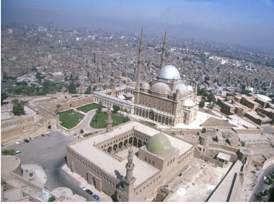
Şekil 13. Kahire Kalesi'nin Güneybatı Bölümü (Nasır Muhammet b. Kalavun Camii, Mehmet Ali Paşa Camii ve Cevher Sarayı ile Onların Etrafındaki Diğer Binalar)
