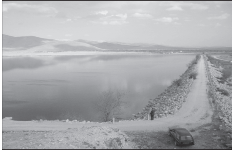
Fotoğraf 1. Toprak Dolgu Setli Akkaya Barajı
