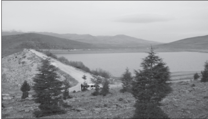
Fotoğraf 5. Toprak Dolgu Setli Gümüşler Barajı
