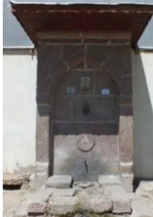
Foto 5: Mahmut Dede Sokağı Çeşmesi
