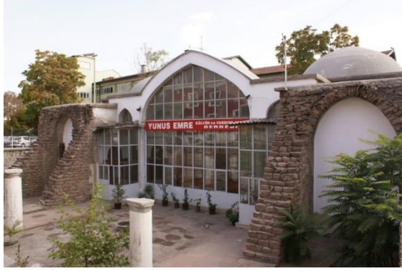
Foto 20: Yapının onarım öncesi durumu
