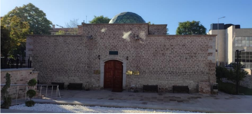
Foto 21: Yapının onarım sonrası durumu
