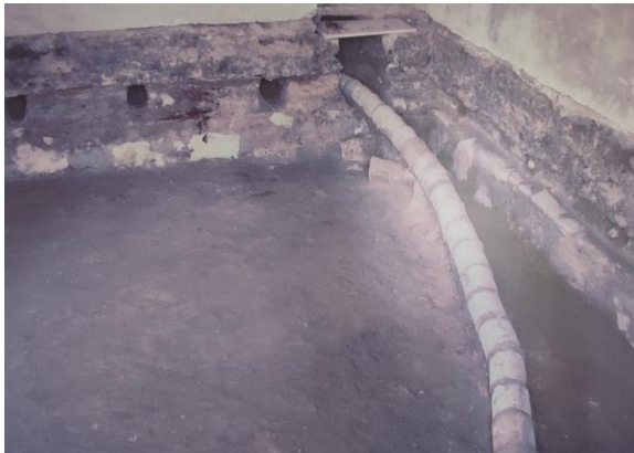
Foto 26: Ortaya çıkarılan su kanalı
