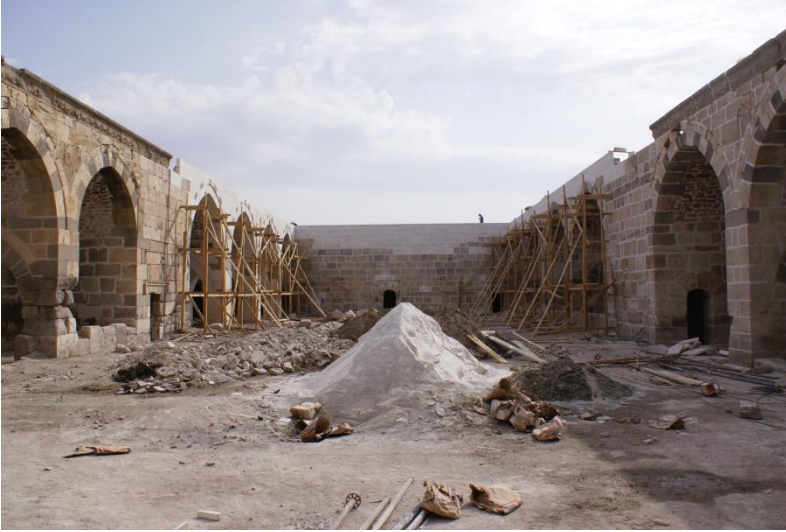
Foto 31: Kervansarayda yapılan restorasyon çalışması
