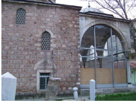
Şekil 47: Kadı Bedrettin Camii kesme taş örgü almaşık ve kesme taş örgü
