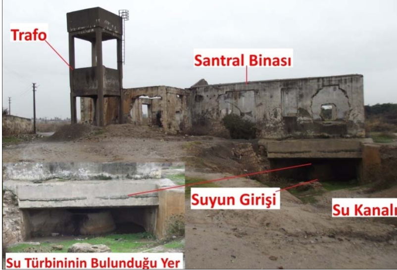
Fotoğraf 5: Tarsus Elektrik Santral Binasının Kuzey Cephesinden Görünümü, 37
