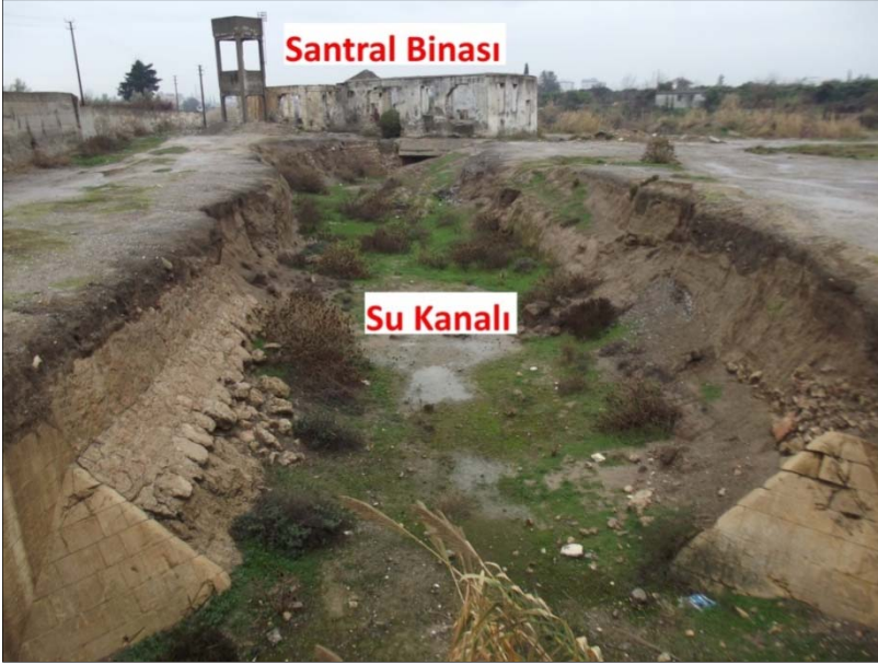
Resim 4: Tarsus Elektrik Santrali Su Kanalı 36
