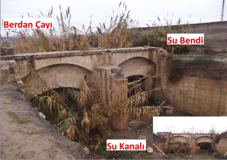
Resim 3: Tarsus Elektrik Santrali Su Bendi, 11/01/2016 35
