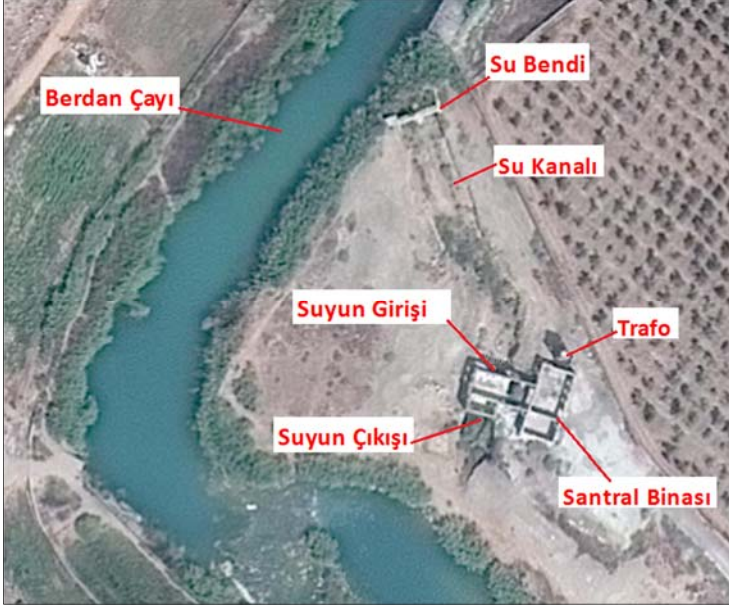
Resim 2: Tarsus Elektrik Santrali Yerleşkesinin Kuş Bakışı Görünümü. 34
