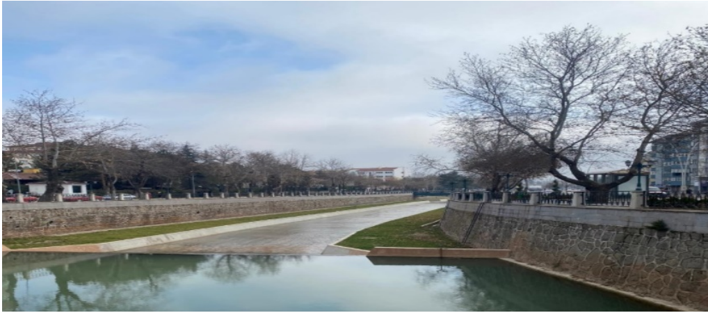
Şekil 4. Tatlıçay'ın mevcut durumu
