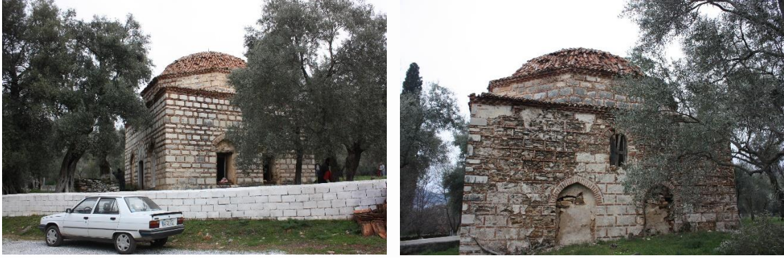
Görsel 8. (sol) Türbe güneybatı cephesi, (sağ) Türbenin doğu cephesi (Foto. Dere, M.E.)
