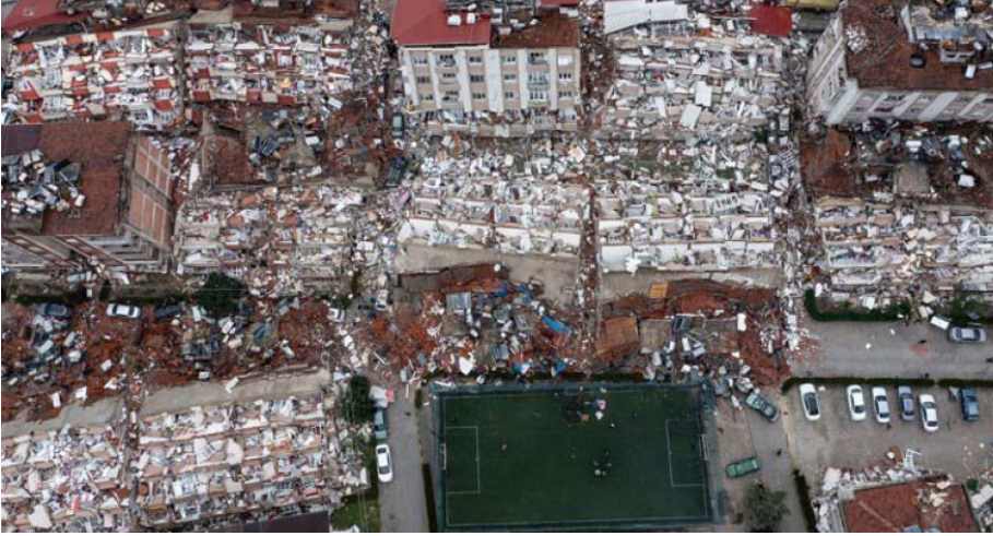
Şekil 5. 6 Şubat 2023 Kahramanmaraş Depremleri – Hatay (TMMOB İMO)
