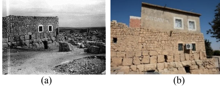
Şekil 11. (a) Zindan adlı yapı, 1977 (Diyarbakır KVKBK Arşivi) (b) Yapının günümüzdeki durumu
