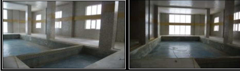
Fotoğraf 7. Yapılmakta Olan Otel İçindeki Sıcak Soğuk Havuzlardan Görünüm. Photograph 7. In Hotel Hot Cold pools in Progress View.
