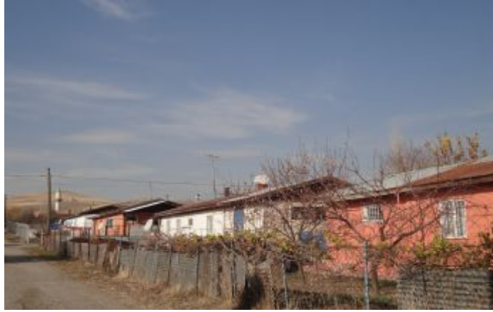
Foto 8: Arguvan'da Yeni Mahallede yapılan afet konutları.
