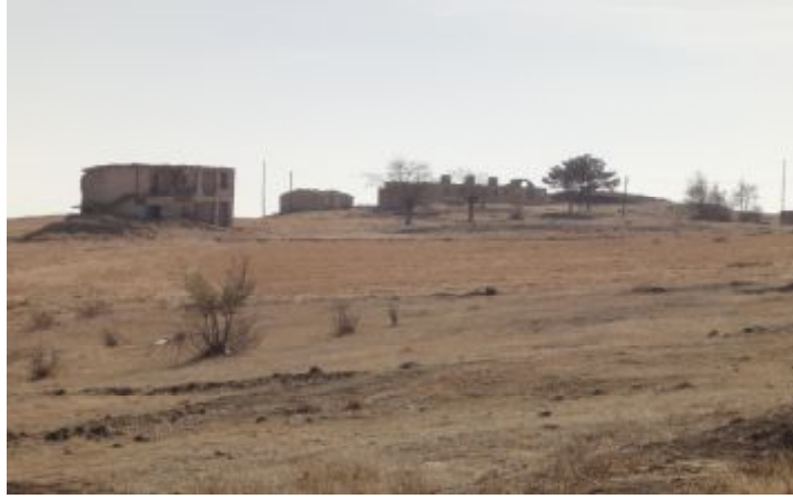
Foto 6: Eski Arguvan'da heyelan sonrasında terk edilen binaların genel bir görünüm.
