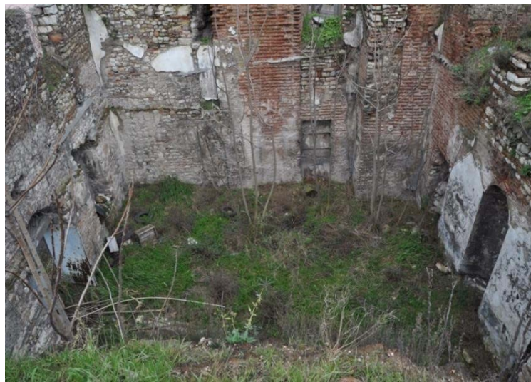
Resim 7. Chalkoprateia Kilisesi Kuzey Duvar (Erbilgin Arşivi, 2010)
