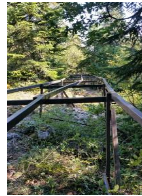
Şekil 16. Ahşap köprü iskelesi
