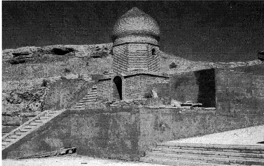
Resim 14. Nahcivan İmamzadesi, II Numaralı Türbe, kuzeybatıdan görünüm
