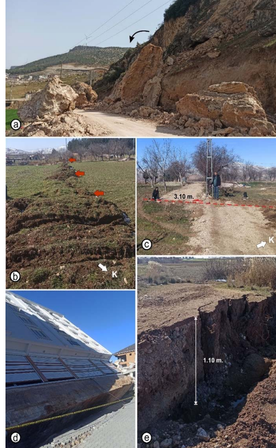
Şekil 12. DAF boyunca Türkoğlu-Gölbaşı yörelerinde görülen deformasyonlar; a) Pazarcık güney kesiminde kaya devrilmeleri ve heyelan, b,c) Gölbaşı Balkar civarında meydana gelen yüzey deformasyonları ve atım, d) Gölbaşı merkezde deprem nedeniyle sivilaşma sonucu yatan bina, e) Gölbaşı civarında arazide gözlenen düşey atım.
