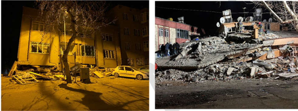
Şekil 21 - Kahramanmaraş Dulkadiroğlu ilçesinde yumuşak kat hasarı ve toptan göçme sonrası vatandaşlar tarafından yürütülen arama kurtarma faaliyetleri
