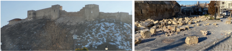
Şekil 32 - Gaziantep Kalesi depremlerden sonra yaşanan hasarlar
