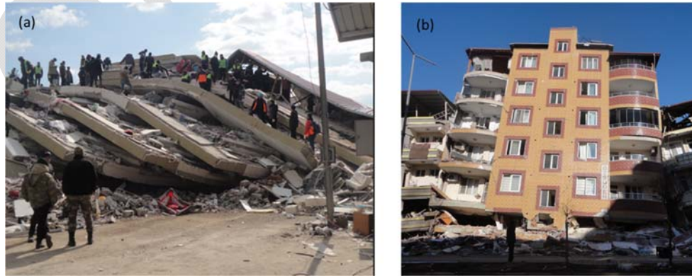
Şekil 22 - Hassa bölgesinde (a) toptan göçmeye maruz kalmış bina (b) yumuşak kat hasarı
