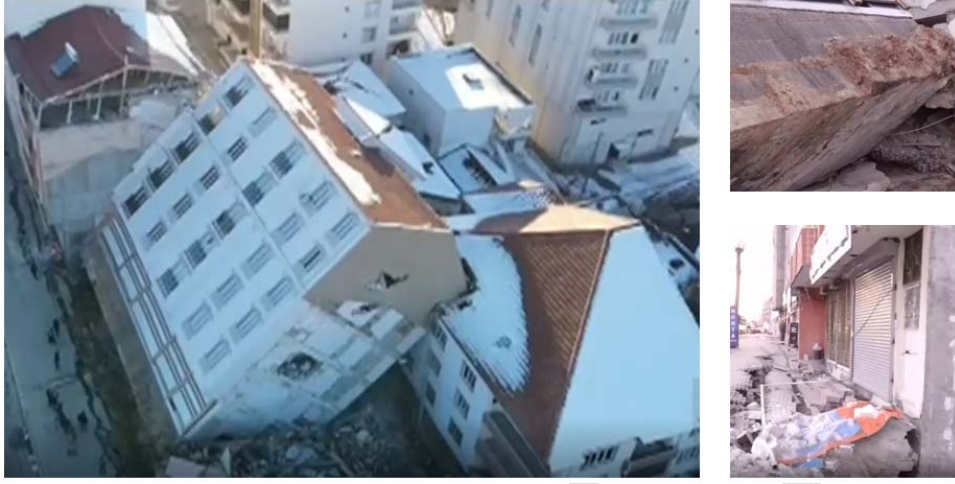
Şekil 36 - Adıyaman ilinde yerel zemin koşullarına bağlı ortaya çıkan hasar ve oturmalar(Anadolu Ajansı)
