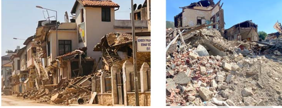
Şekil 33 - Antakya Kurtuluş Caddesinde tescilli kültür varlıklarında yığma yapı hasarları
