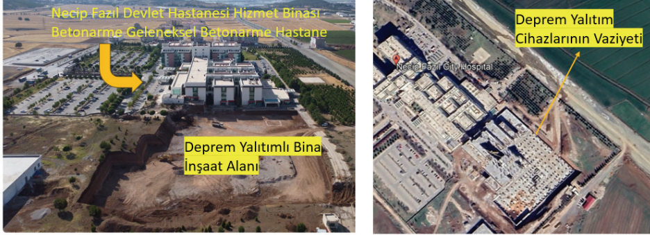
Şekil 30 - Kahramanmaraş ilinde inşası devam eden deprem yalıtımlı hastane binasının inşaa süreci( Fotoğraflar TIS firması izniyle firmanın proje kataloglarından ve uydu görüntülerinden alınmıştır)
