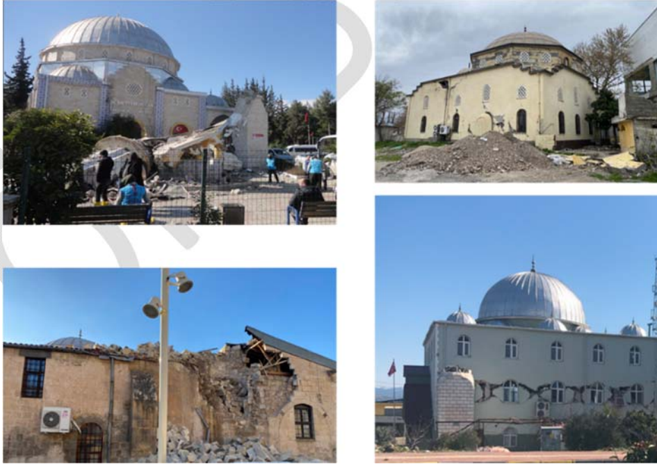
Şekil 34 - İbadethanelerde gözlemlenen taşıyıcı ve taşıyıcı olmayan yığma duvar hasarları
