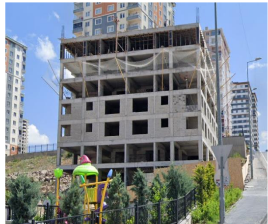
Şekil 7. Betonarme çerçeve sistem bina örneği
