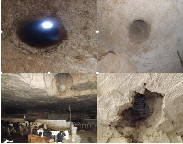
Şekil 10. Mağaralarda doğal oluşum havalandırma baca örnekleri.
