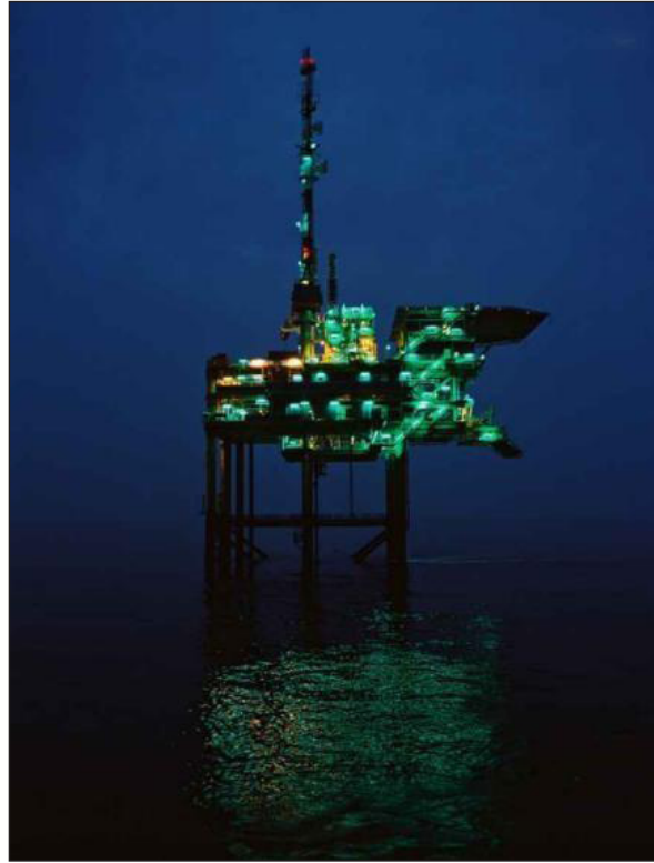
Şekil 9. Açık renk önerileri dikkate alınarak Nederlandse Aardolie Maatschappij (NAM) açık deniz gaz üretim platformu L15'in fotoğrafı (Poot ve diğerleri, 2007)
