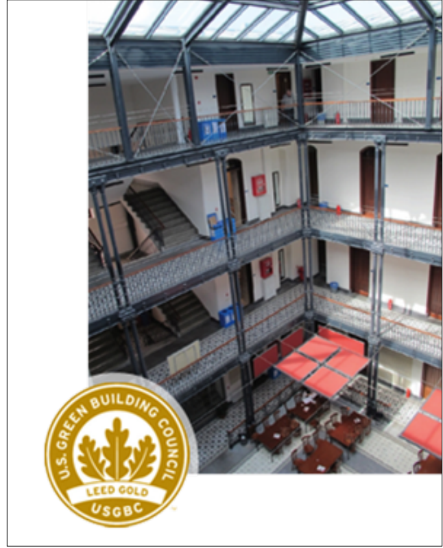
Şekil 6. Boğaziçi Üniversitesi LEED Gold sertifikalı Hamlin Binası
