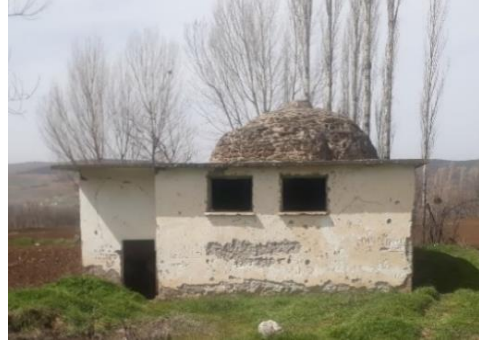
Hamamın kuzey görünüşü
