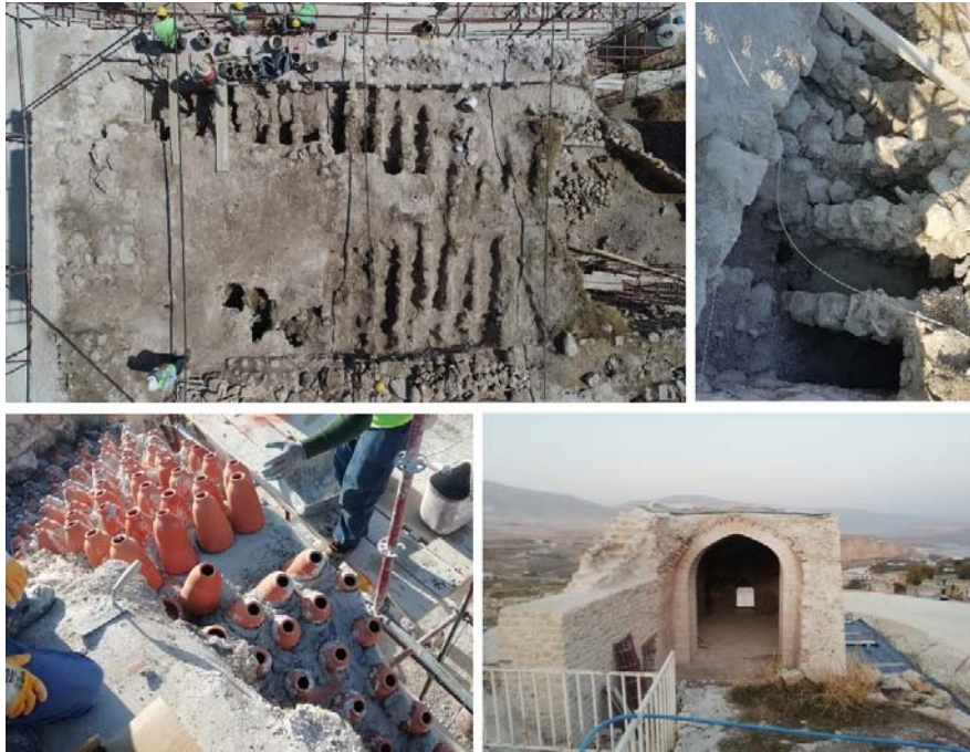
Şekil 7. Küçük Saray çift katmanlı çatı detay ve onarımı (Small Palace double-layer roof detail and repair)
