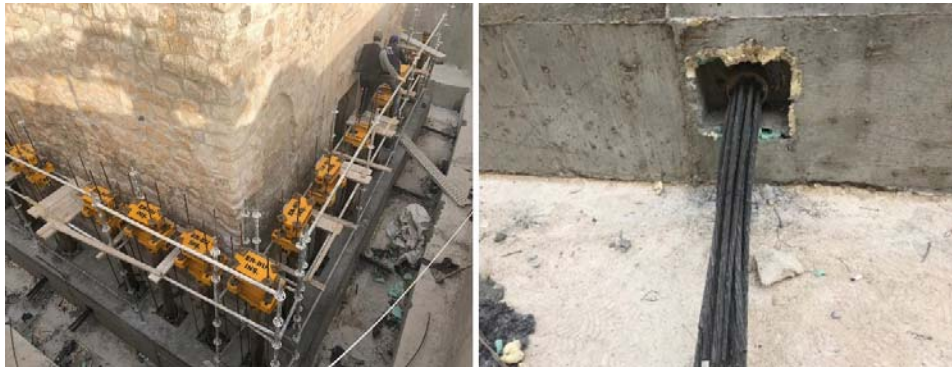
Şekil 13. Hidrolik krikolar ve ard germe (Hydraulic jacks and post tensioning)
