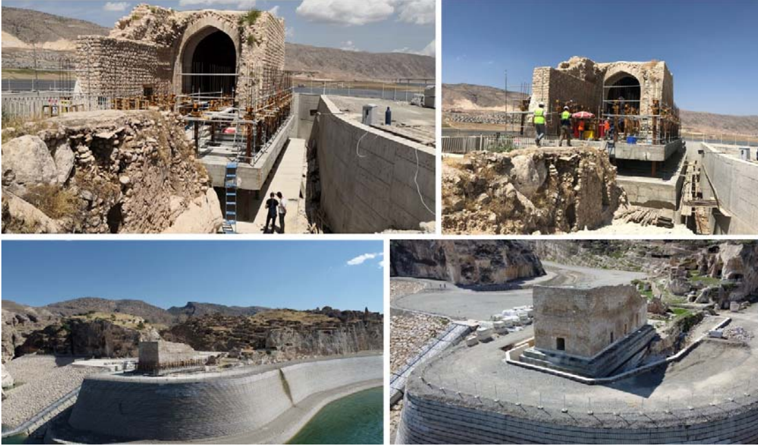
Şekil 14. Küçük Saray'ın yerinde yükseltme aşamaları ve uygulama sonrası görünümü (Small Palace on-site raising stages and post-implementation view)
