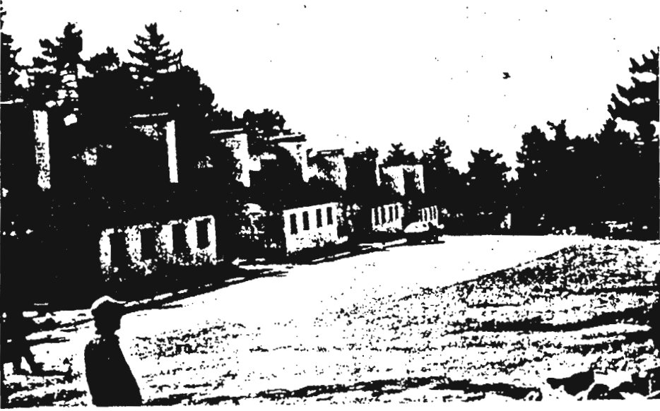
Fotoğraf 2. Turizm Merkezinin En Modern Tesislerini Oluşturan Betonarme Tatil Konutlarından Bir Görünüm.
