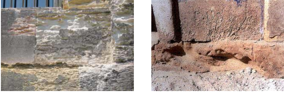
Şekil 12. Atmosferin etkisiyle taşlarda oluşan bozulma örnekleri
