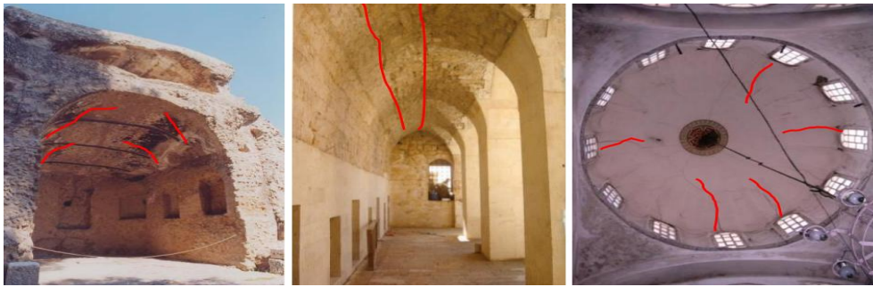
Şekil 9. Yerçekimin tonoz ve kubbelerde oluşturduğu çatlak tipleri
