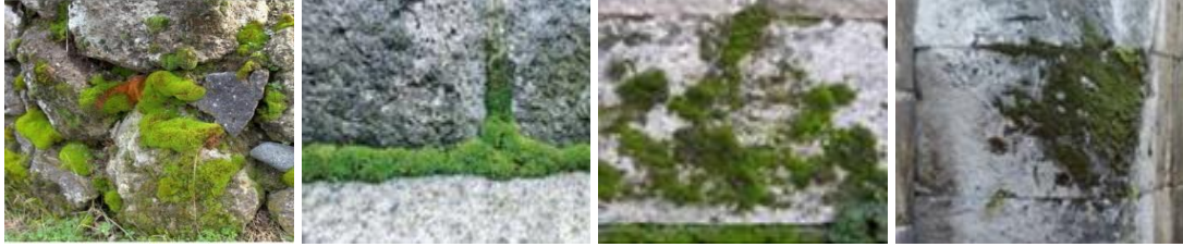
Şekil 17. Taş yüzeylerinde ya da derzlerinde meydana gelen yosun oluşumları
