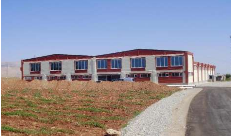
Fotoğraf 1: Modern Tarzda İnşa Edilmiş Bir İşletme (Dilan Bebe Tekstil İşletmesi)
